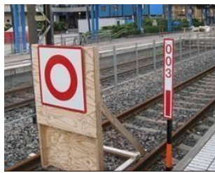
Kuva 2. SEIS-levy. Tätä merkkiä on käytettävä aina, kun rata suljetaan liikenteeltä ratatyön ajaksi.
