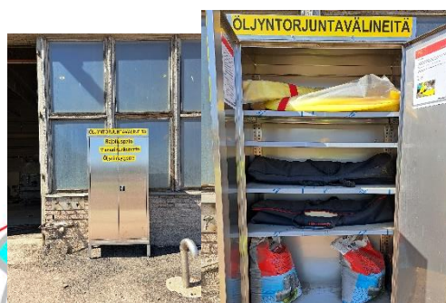
Korjaamolla öljyntorjuntakaappi, jossa viemärensulkumattoja sekä imeytysainetta
