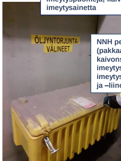
NNH uuttorakennuksen oven nro. 26 takana on mm. imeytysmattoja, imeytysliinoja, imeytysainetta, kaivonsulkumattoja ja imeytyspuomeja
