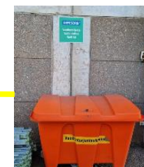
NNH liuottamon alueella öljyntorjuntalaatikkoja, joissa imeytysainetta ja viemärensulkumattoja
