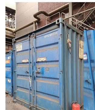
Kuivaamon vieressä öljyntorjuntakontti, josta löytyy mm. viemärensulkumattoja ja imeytysainetta
