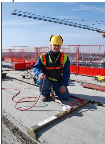
Kuva 5. Korkean paikan töissä esim. katoilla työskenneltäessä käytetään aina putoamissuojaimia.
