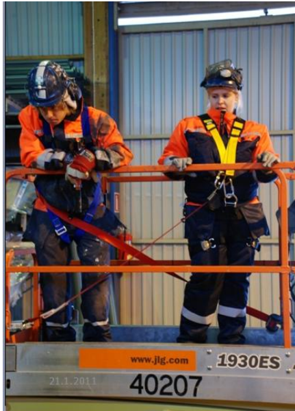
Kuva 7. Myös saksinostin on henkilönostin ja siellä työskenneltäessä on käytettävä putoamissuojaimia. Myös nostimen vakavuus ja alustan kantavuus on varmistettava.
